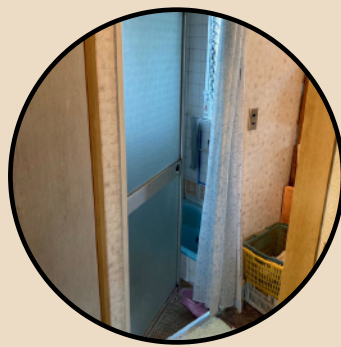
扉の取り換え
